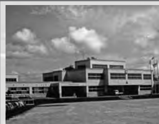
本桐小学校改築工事 6月15日
