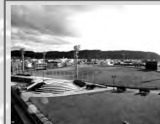
古川公園野球場完成 5月26日
