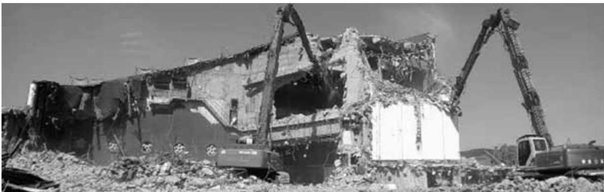
旧静内文化センター・図書館解体工事
