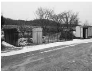
上水道4号取水井戸地点
