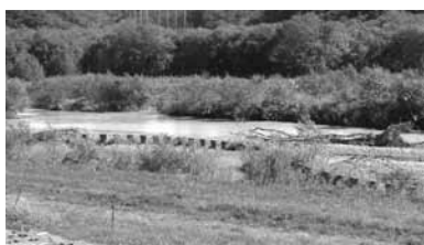
ふれあい広場の被災状況
