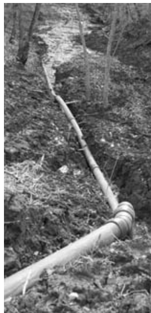
漏水部分の仮応急復旧工事
