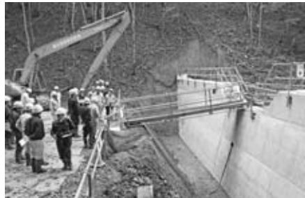
大下の沢復旧治山工事
