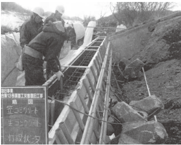
農地復旧工事
