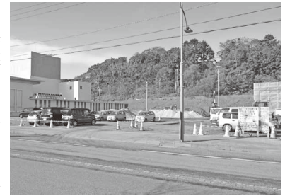
総合町民センター外構工事
