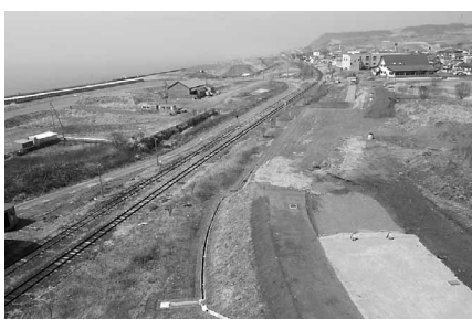
本町海岸線工事現場
