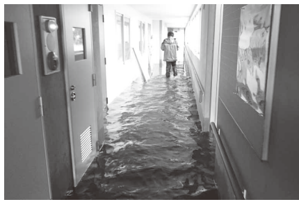
静内御幸町道営住宅の浸水
