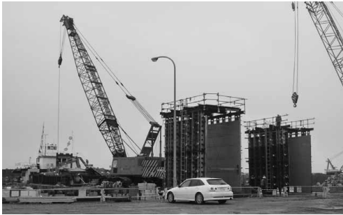
漁港内において埠頭を建設中
