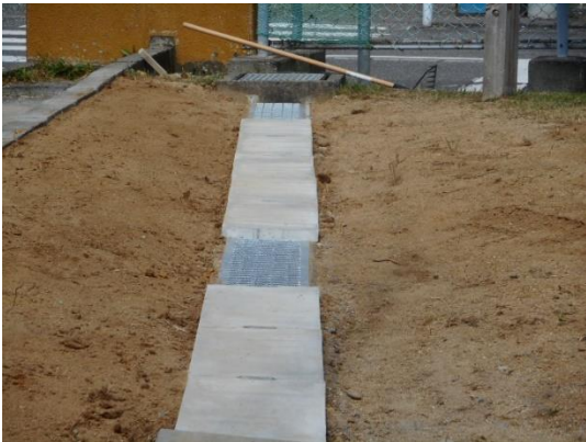
体育館前のU字溝
