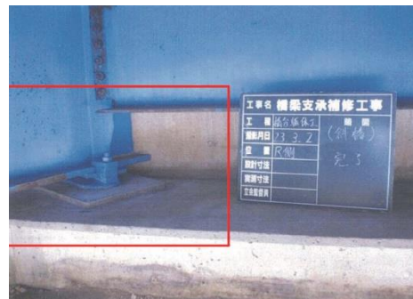
修繕工事にて補修
